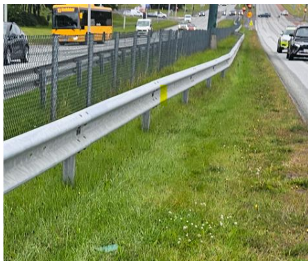
Mynd 3. Á umferðareyjunni var tvöfalt vegrið og vírnet á milli.
