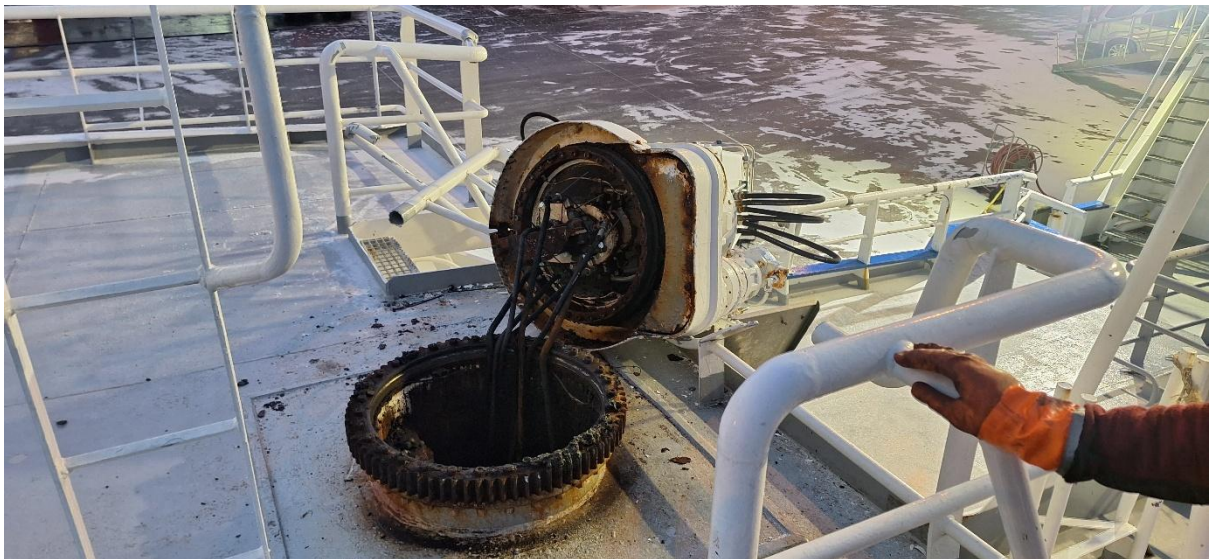
Mynd 3. Festing pilfarskrana.
