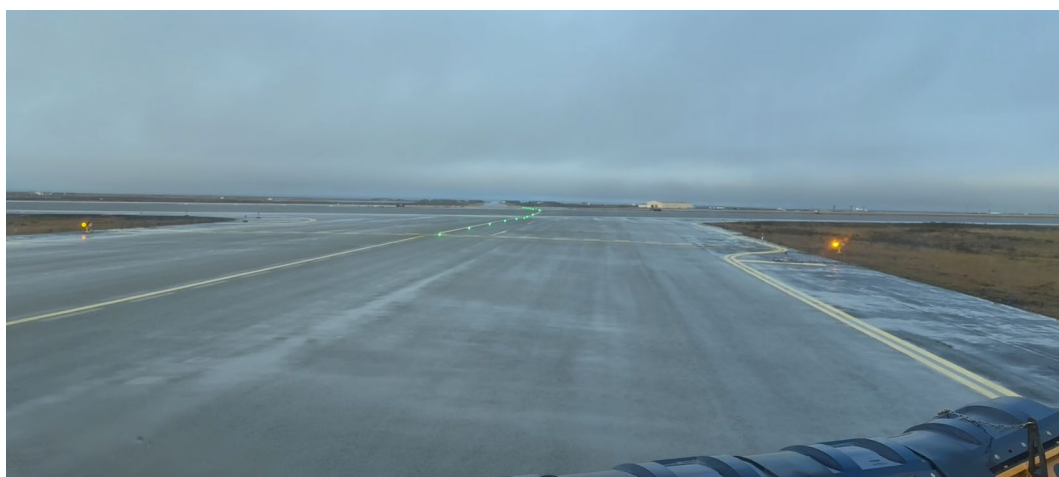
Mynd 8: Mynd af akbraut S-1 tekin úr FROST 10 þegar aðgangur að flugbraut um akbrautina er opin með grænum miðlínuljósum þvert yfir flugbrautina
