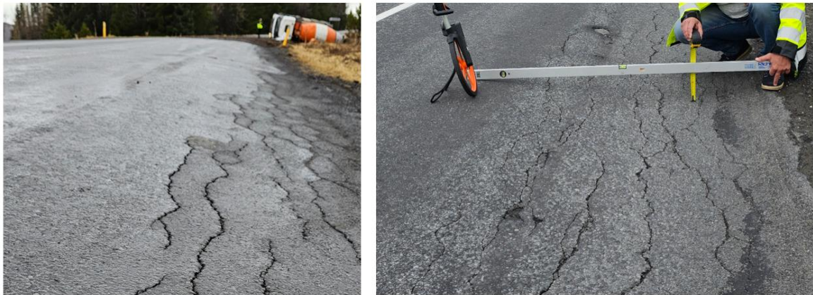
Mynd 5. Samsett mynd sem sýnir brot í klæðingu og mælingu þar sem hluti eystri akreinar, í akstursstefnu vörubifreiðarinnar, hafði sigið niður.
