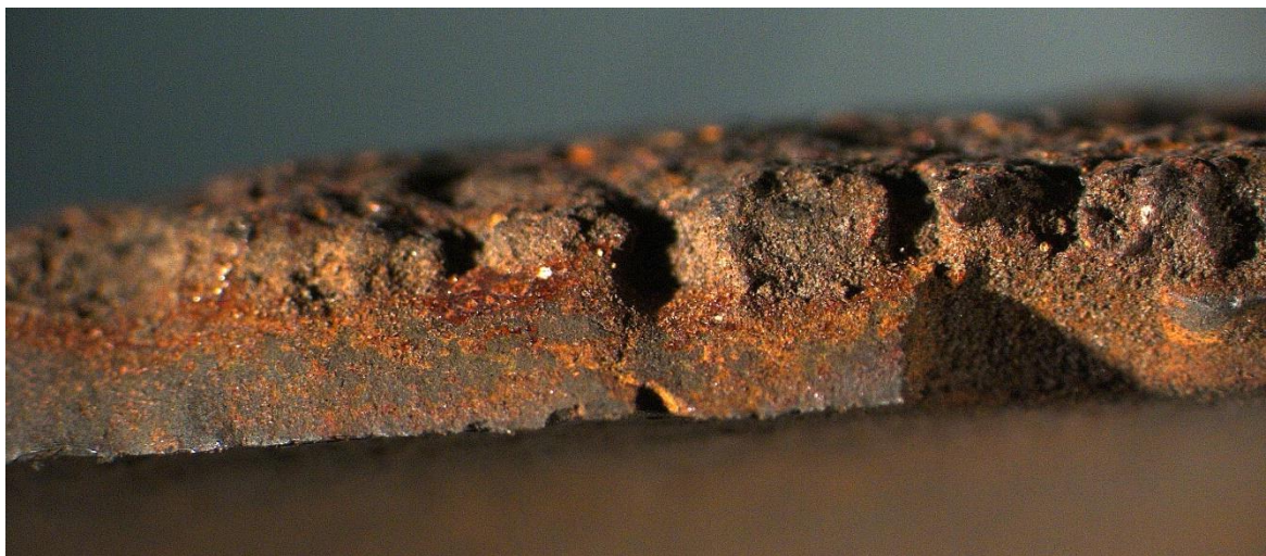
Mynd 2: Nærmynd af rifunni á geyminum. Djúpir tæringarpittir sjást greinilega.
