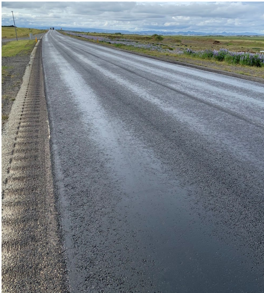
Mynd 2: Mynd tekin um kl. 9 föstudagsmorguninn við vigtarplanið við Blikdalsá. Talsverðar blæðingar má greina á myndinni. Mynd fengin frá Vegagerðinni.
