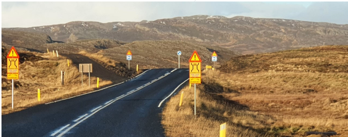
Mynd 2: Uppfærðar merkingar við slysstað. Mynd fengin frá Vegagerðinni.
