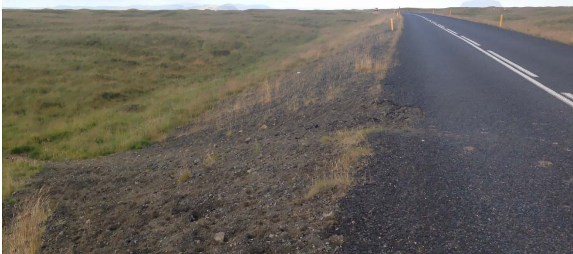
Mynd 4: Brotið var upp úr slitlagi í vegbrún beggja vegna þar sem reiðstígur lá yfir veginn fyrir tæplega 200 metrum norðan við slystað.
