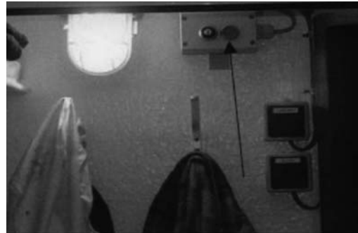
Mynd 2. Örin sýnir rauða hnappinn á afhleypirofa. Læsing fyrir lykilinn er við hliðina.
