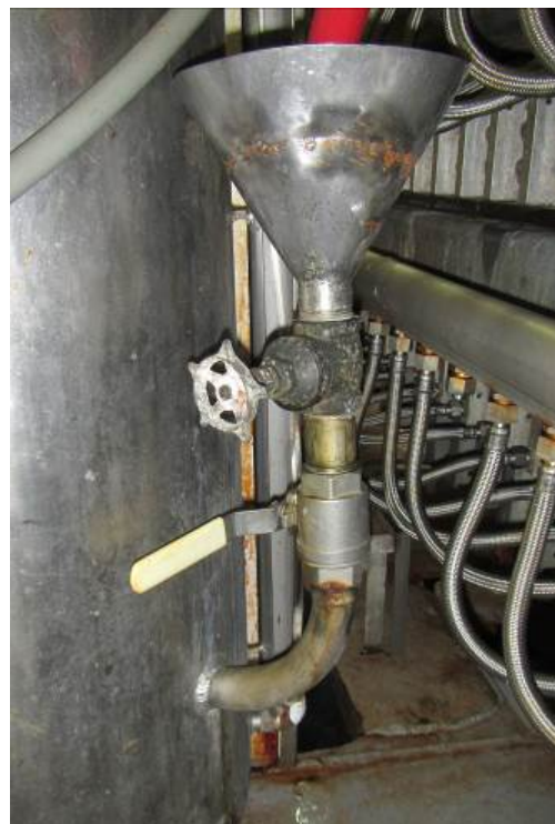
Mynd 3 Áfyllitrekinn á sápublöndunartanknum
