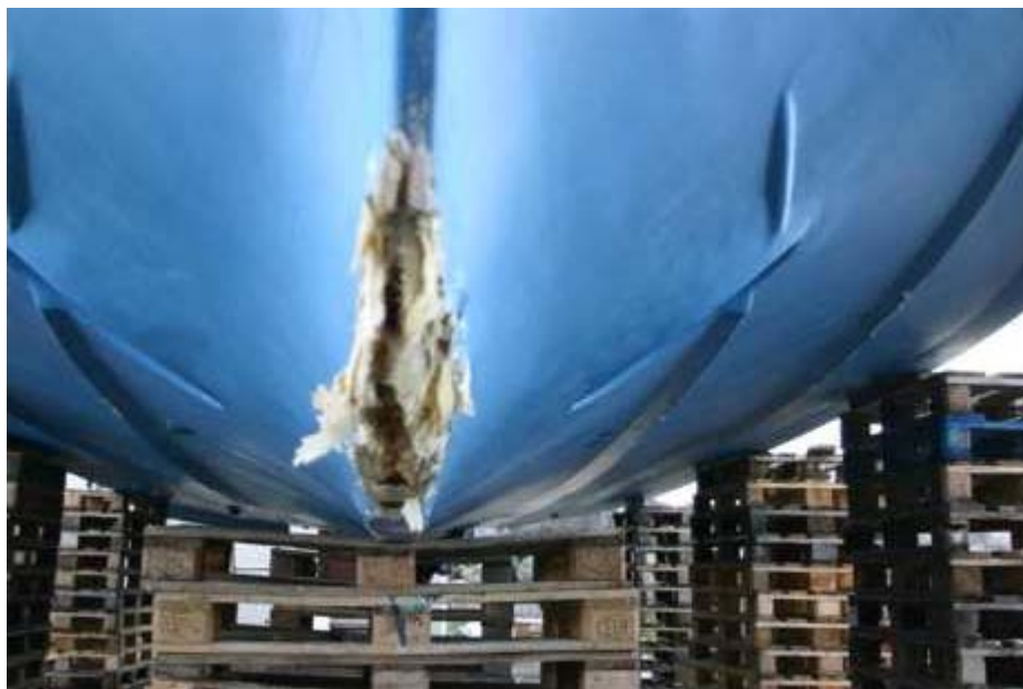
Skemmdir á stefni, fyrir neðan perustefni.
