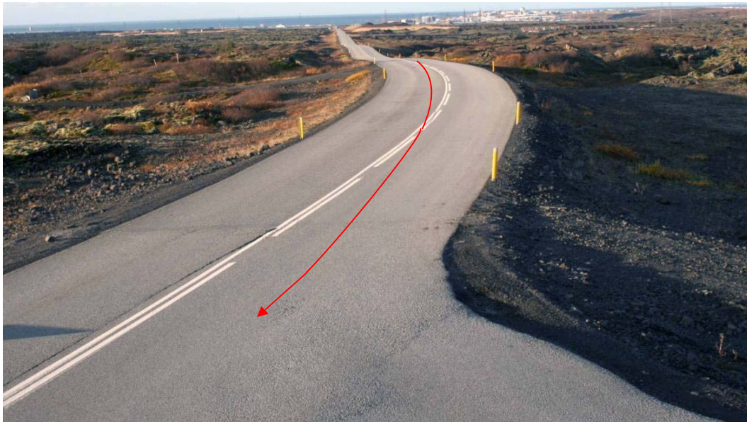
Horft móti akstursstefnu bífhjólsins norðvestur Krýsuvíkurveg.
